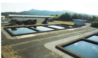
山の内浄水場
