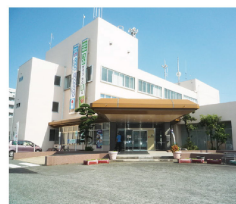
外壁塗装が完了した役場庁舎
