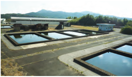
山の内浄水場
