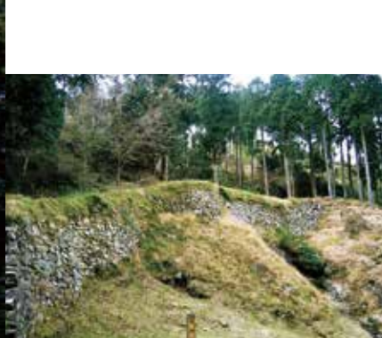
古代山城の「百間石垣」 全長約180mの大野城跡最大の石垣。 内部まで石を積めた「総石垣」構造となっ ています。石垣の一部に隙間があり、そこから 水が流れていることから、水門の一部と考え られています。
