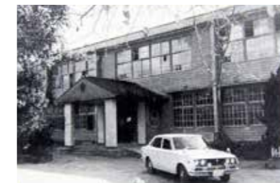
②原田小学校 昭和9.4.1竣工(木造瓦葺平屋2棟)
