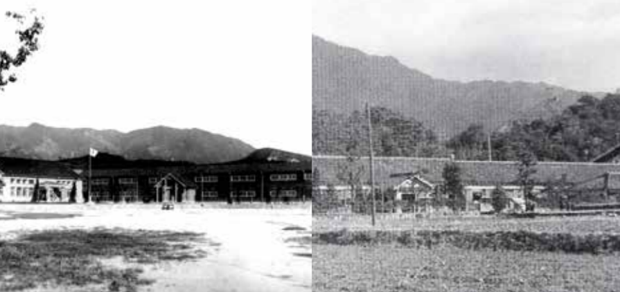
⑨宇美中学校 昭和25年4月1日竣工 木造瓦葺2階2棟(昭和27年撮影)
