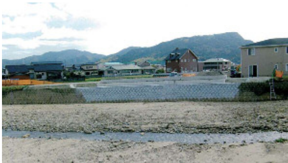
▲光正寺・井野線橋梁工事
