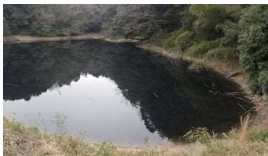
下流側から見た様子
