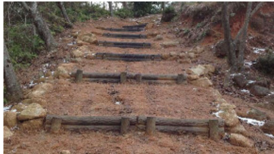
▲平成26年度、修理された遊歩道
