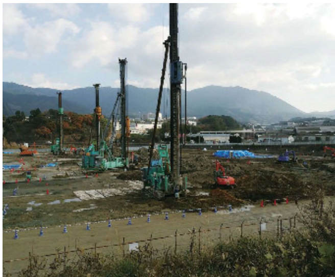
町内に大型物流施設が着工
