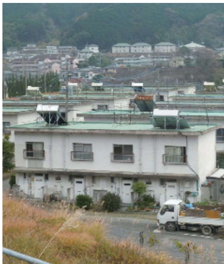
昭和町 町営住宅
