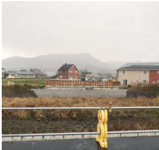
光正寺井野線橋梁工事
