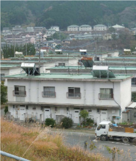
昭和町 町営住宅
