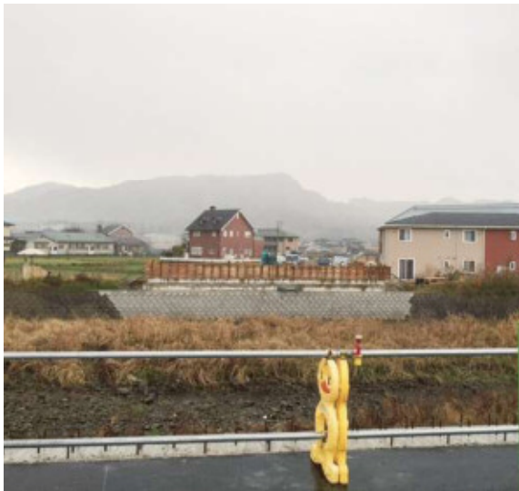
光正寺井野線橋梁工事
