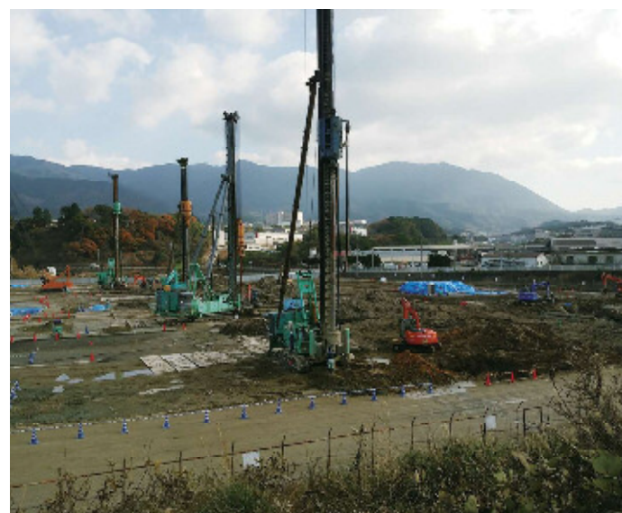
町内に大型物流施設が着工
