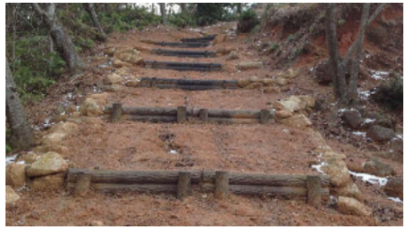
▲平成26年度、修理された遊歩道
