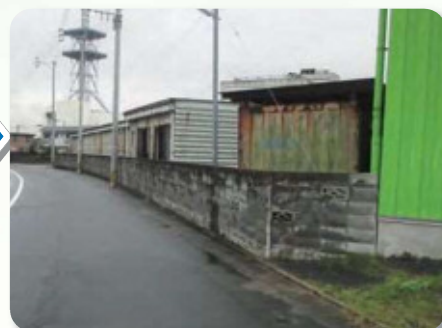
役場裏ブロック塀(改修前)
