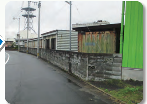
役場裏ブロック塀(改修前)
