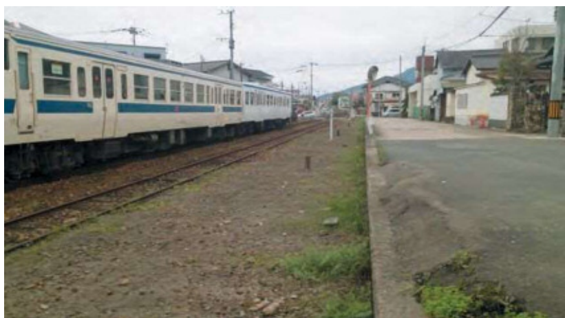
▲ガードレールの設置を検討
