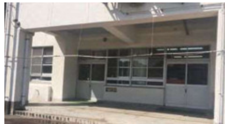
ミストシャワー (井野小学校保健室付近)
