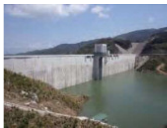
試験混水中の五ヶ山ダム
