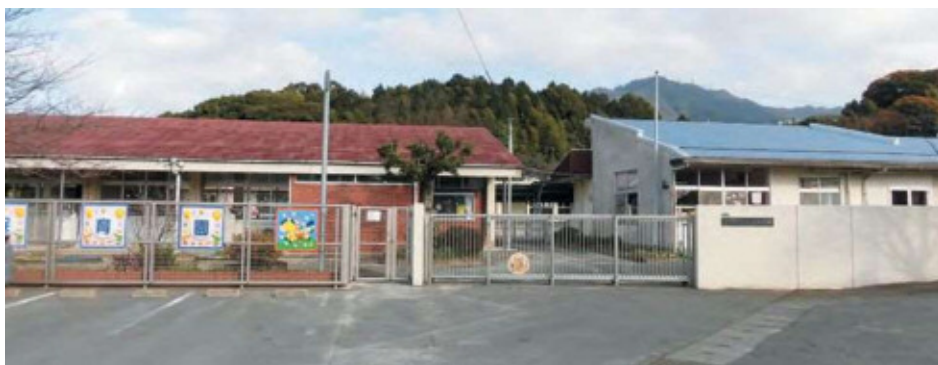
建築後 41 年経過した柳原保育園
