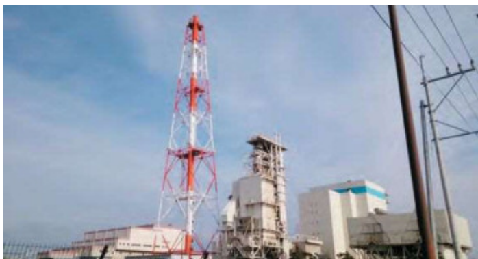
▲大牟田リサイクル発電所
