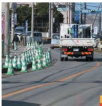
ひばりが丘入口修繕工事
