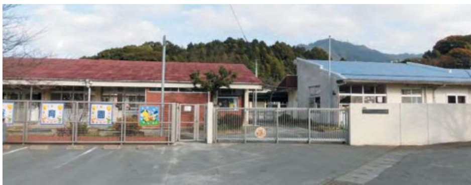
建築後 41 年経過した柳原保育園
