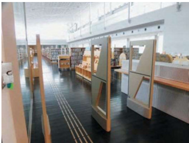
町立図書館入口ブックディテクションシステム
