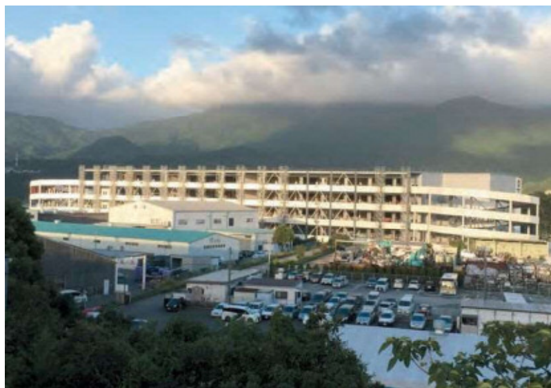
町内に建設中の大型物流施設
