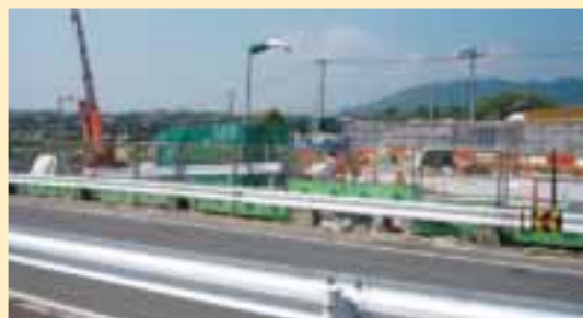
▲③県道筑紫野古賀線（正法橋）
