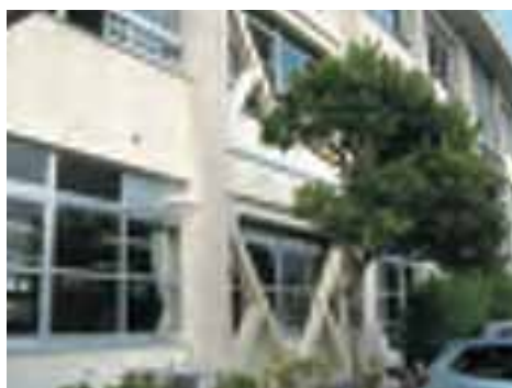
耐震工事を行った校舎
