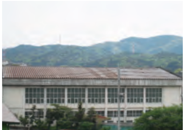
▲宇美中学校屋根補修工事予定
