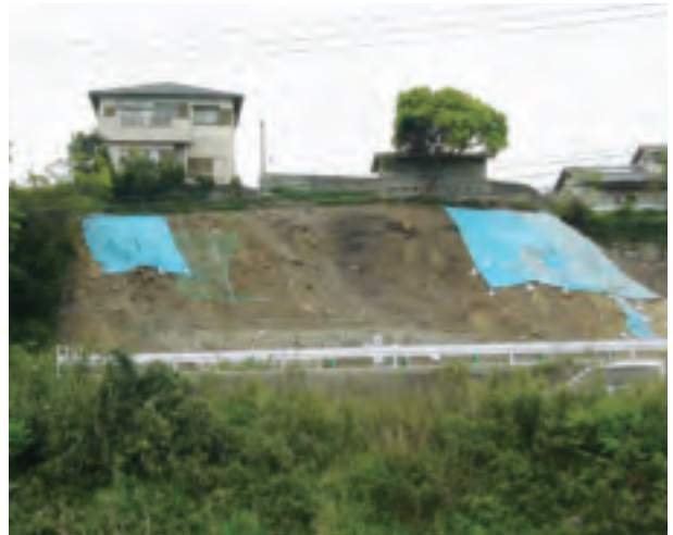
▲平和 1 丁目地内法面崩壊防止工事
