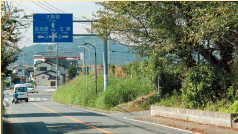
上北川橋交差点改良
