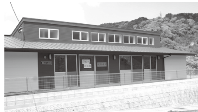
完成した貴船区公民館
