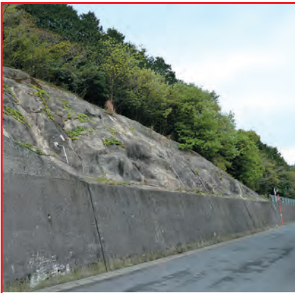
ひばりが丘3丁目地内 法面補修工事 2,205万円
