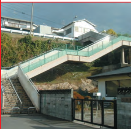
林崎歩道橋改修工事 1,000万円
