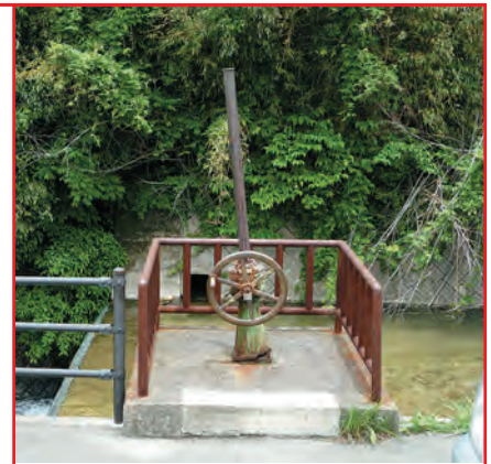
六反田堰開閉機取替工事 164万5千円
