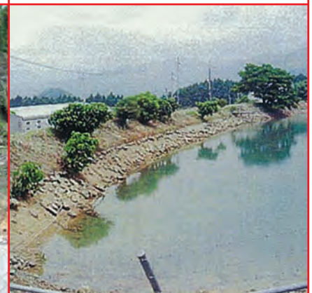
中ノ原池斜樋改良工事 525万円
