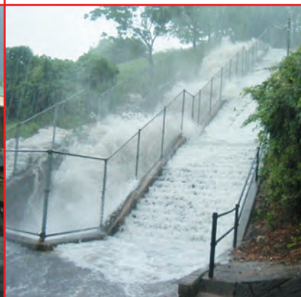
四王寺坂地内排水路補修工事 500万円
