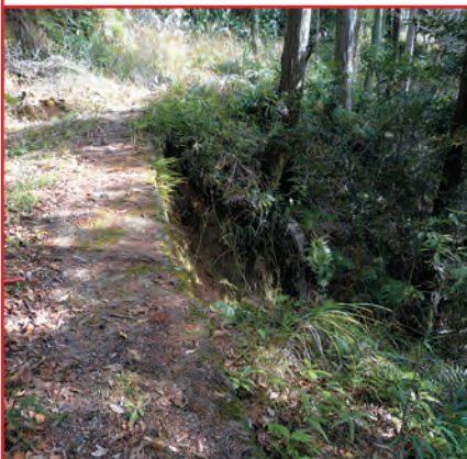
林道割石支線2号整備工事 900万円
