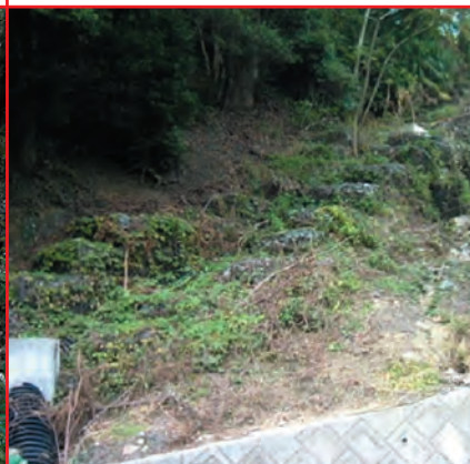
ゆりが丘6丁目地内 排水路補修工事 450万円
