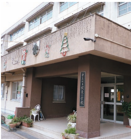
▲防犯カメラ設置
