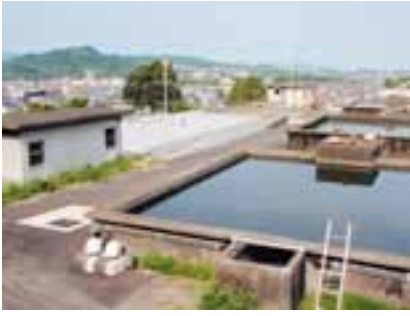
▲施設の老朽化による拡張工事
