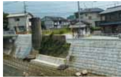
▲改修された上北川橋付近
