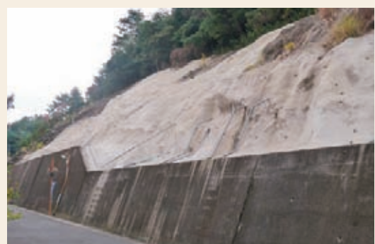
ひばりが丘3丁目地内法面補修工事 2,060万円
