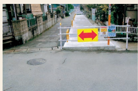
町道黒穂中央区線通路拡幅工事ほか 8,072万円
