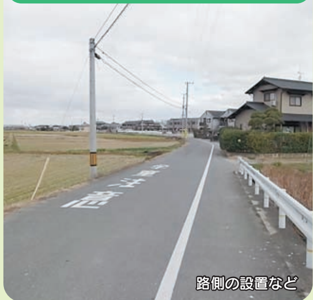
井野小学校区 竹ヶ下橋付近
