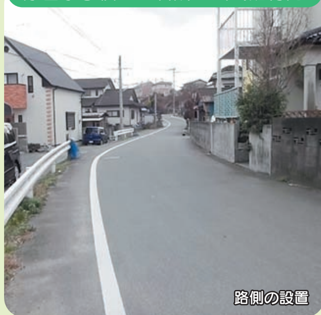
原田小学校区 新成区公民館付近
