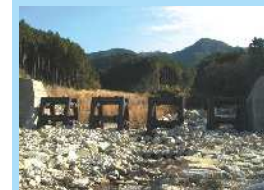
流木などを防ぐダム
