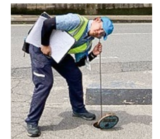
弁類の確認状況
