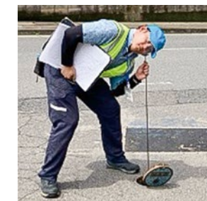
弁類の確認状況
