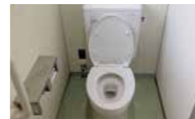
改修済みの町内小学校のトイレ
