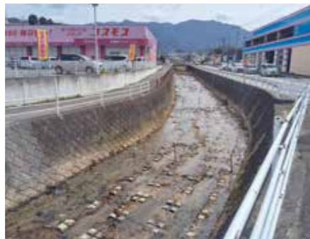
浚渫工事が行われた井野川
