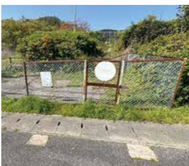
火災時に使用する防火水槽
