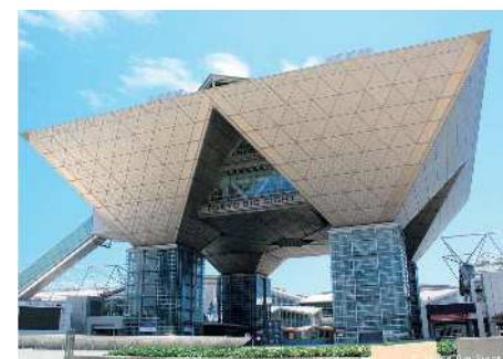
東京ビッグサイト (熱源空調工事)
