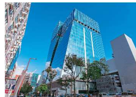
福岡大名ガーデンシティ (熱源空調工事)
