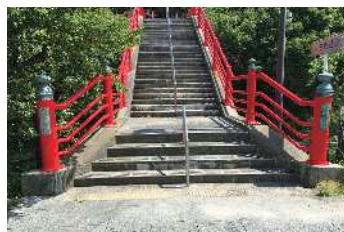
子安新橋 (高欄工事)
