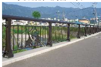
正法橋 (高欄工事)
