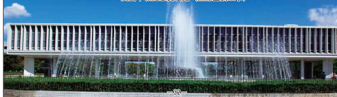
広島平和記念資料館 (熱源空調工事)
