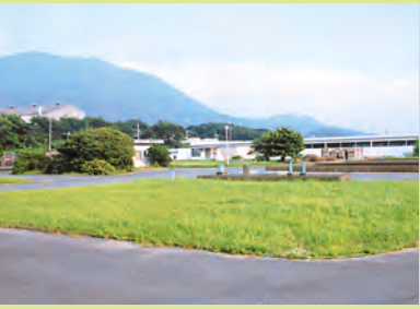
配水池 (水を地下にためておきます)
