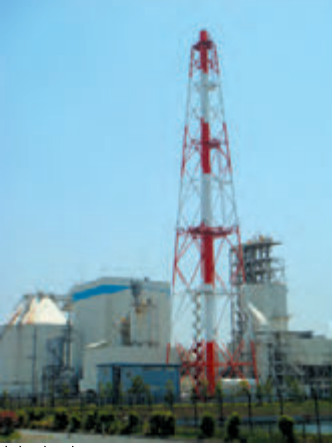
大牟田リサイクル発電所
