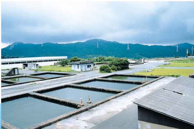
山の内浄水場の施設
