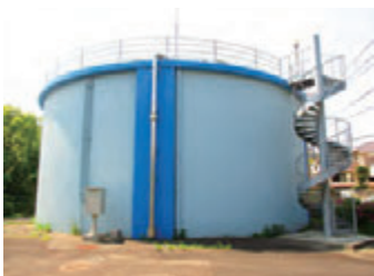
観音浦配水場
