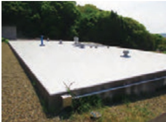
柳原浄水場・配水場
