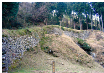
全長約180m。大野城跡最大の『百間石垣』は強固な「総石垣」構造に。また『増長天礎石群』をはじめ、山中には至るところに礎石群が残っている
