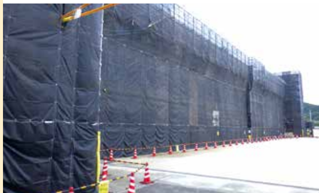
改修中の宇美小学校校舎
