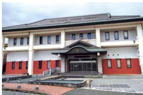
避難所としても活用される宇美町立武道館
