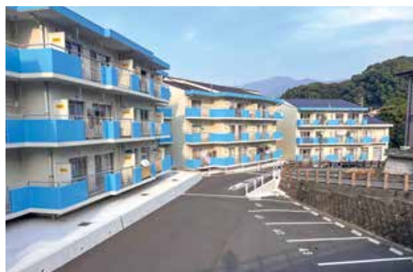
駐車場の増設と施設長寿命化が行われた原田中央区町営住宅
