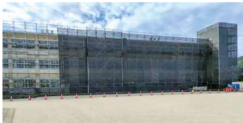
外壁等改修工事が進み施設の長寿命化が進む宇美小学校校舎
