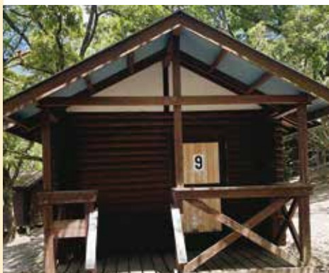
現在使用されていないバンガロー
