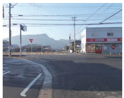
平成29年3月の完成を目指し、用地買収と工事を進めています。
