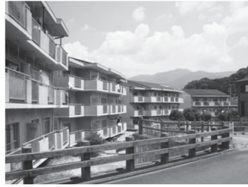
原田中央区町営住宅整備工事
