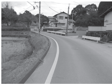
町道炭焼～新田原線 歩道設置工事
