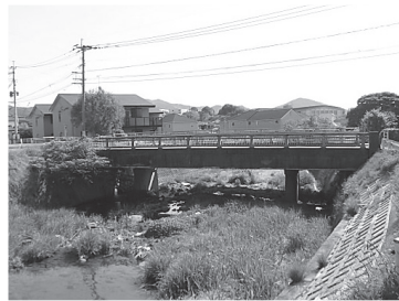
六反田橋・大橋・畑田橋 橋梁修繕工事
