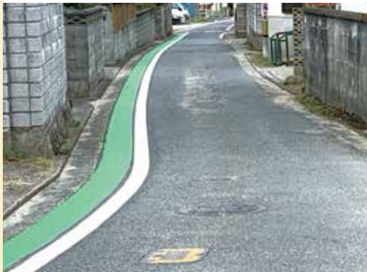
狭く危険な通学路にグリーンベルト設置
