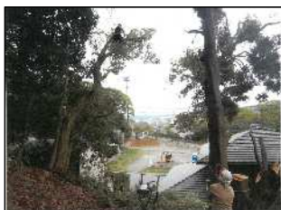
（事業1：施工状況）
