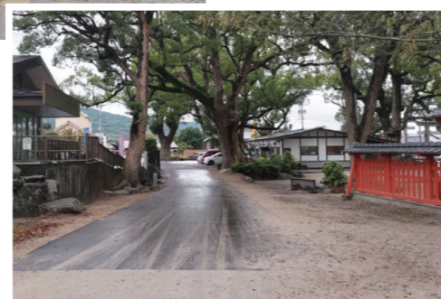
アスファルト舗装後▶
