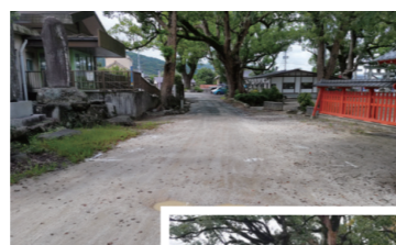
◀アスファルト舗装前
