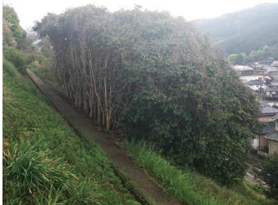
側溝に覆いかぶさっていた樹木を剪定
