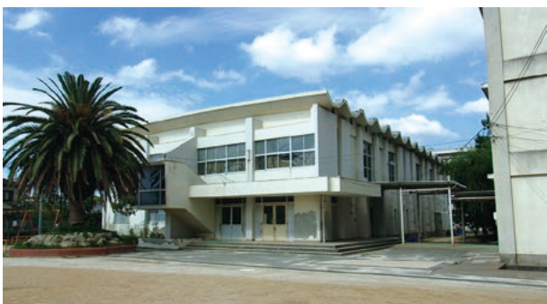
老朽化した宇美小学校体育館
