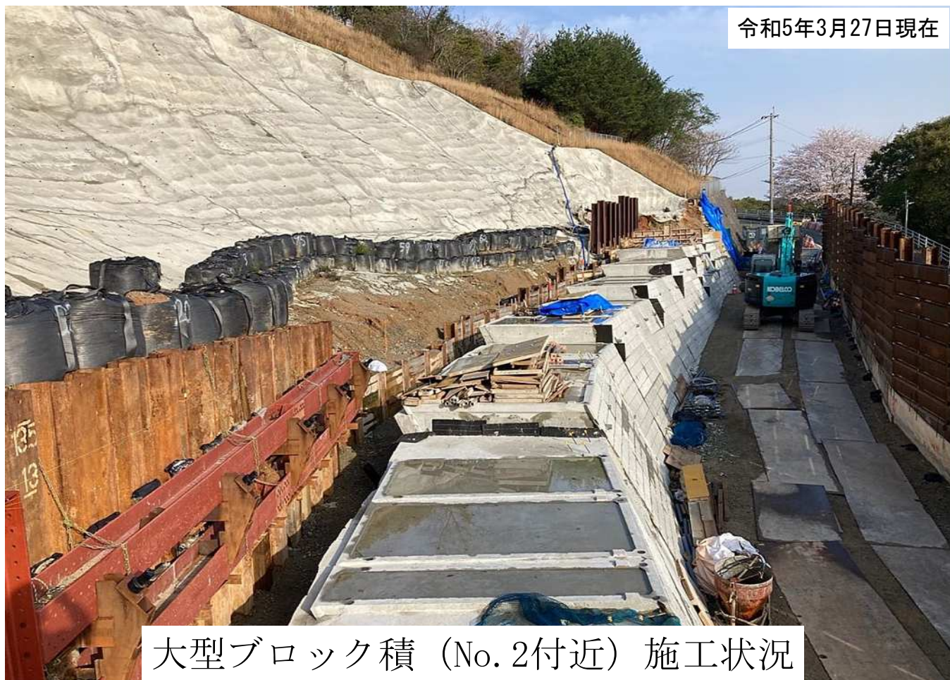
大型ブロック積 (No. 2付近) 施工状況
