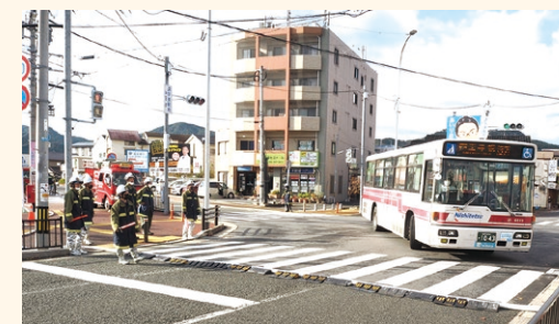
▲ 県道にブリッジを設置しホースを通す
