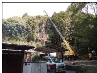
（事業1：施工状況）
